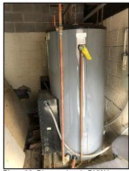
Photo 82. Rheem electric DHW heater
